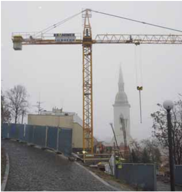
Bytový dom vo výstavbe.
