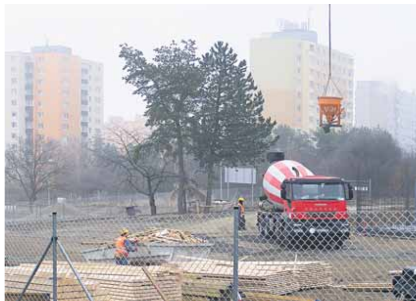
Bude stačiť za rušnú noc iba ospravedlnenie?
