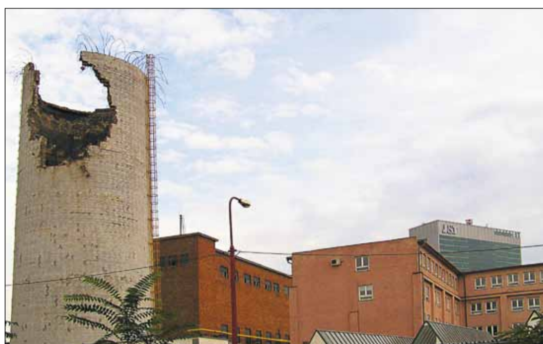
Do miznúceho komína na Čulenovej ulici sa zahryzol špeciálny stroj, no údajne sa pokazil, a tak sa dostali k práci opäť tí, ktorí ho do súčasnej výšky odvrátili zo 120 metrov.
