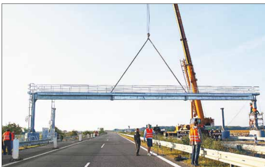
Diaľničná spoločnosť osadila na bratislavský úsek diaľnice D2 ocelovú konštrukciu mýtnej brány. Na konštrukciu bude nainštalovaný elektronický mýtny systém.
