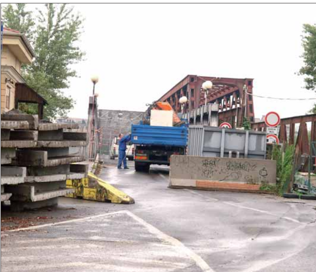
V rámci rozoberania Starého mosta už z neho odviezli takmer 250 betónových panelov – mostovky. Počas najbližších mesiacov by mal most prísť už aj o svoju ocelovú konštrukciu. foto mk
