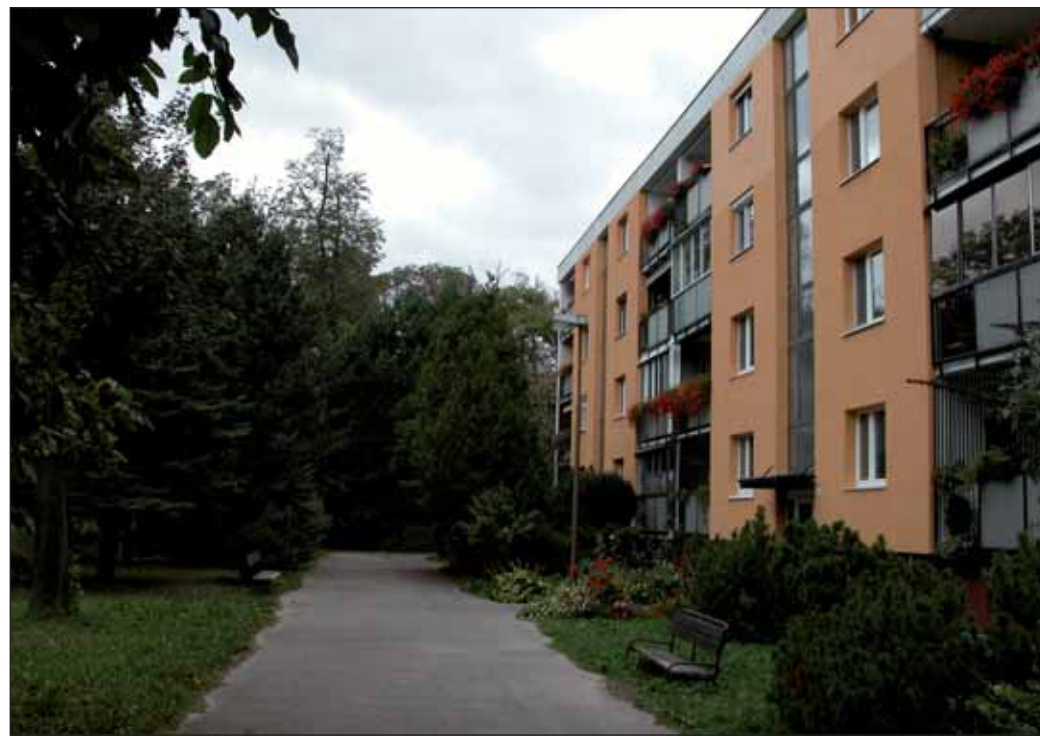
Podľa investora okolie bytovky ostane nezmenené, je to totiž stále mestský pozemok.
