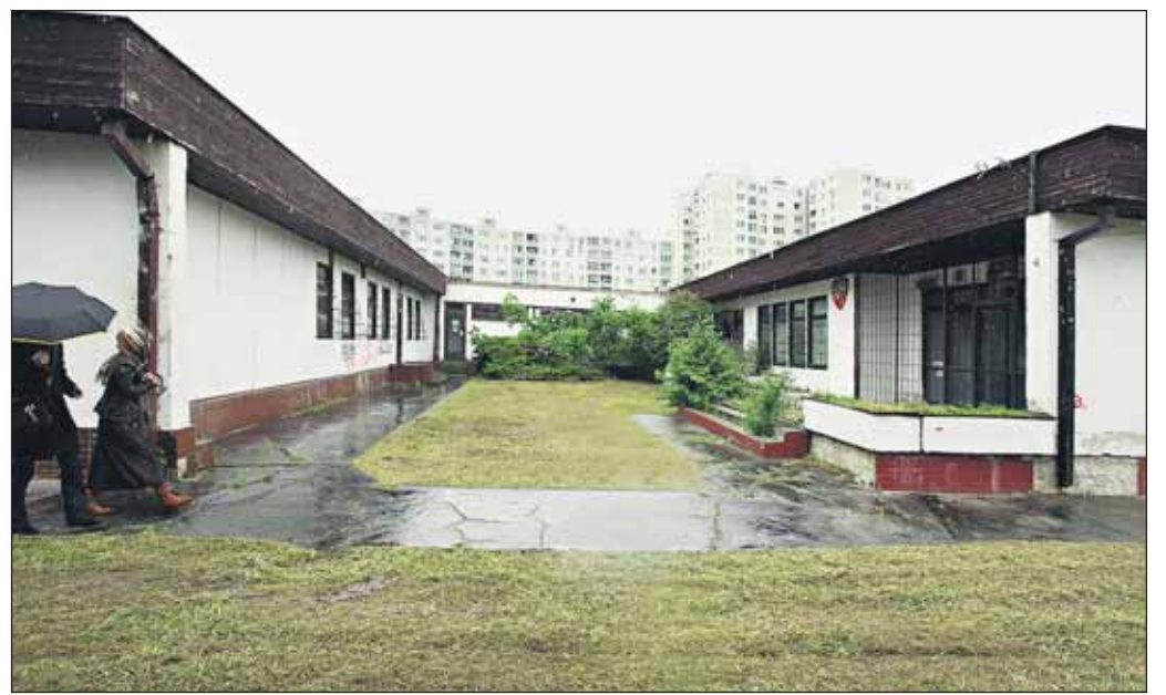
Krízové centrum otvoria po rekonštrukcii v priestoroch bývalej materskej školy na Budatínskej ulici 59/A v Petržalke. Otvoriť by ho mali po marci 2011.
