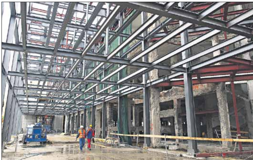
Zvnútra je to zatiaľ jedno veľké stavenisko.
