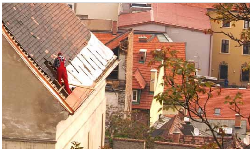
Pravoslávny historický kostol na Mikulášskej ulici dostáva krajší šat v podobe novej strechy a fasády.
