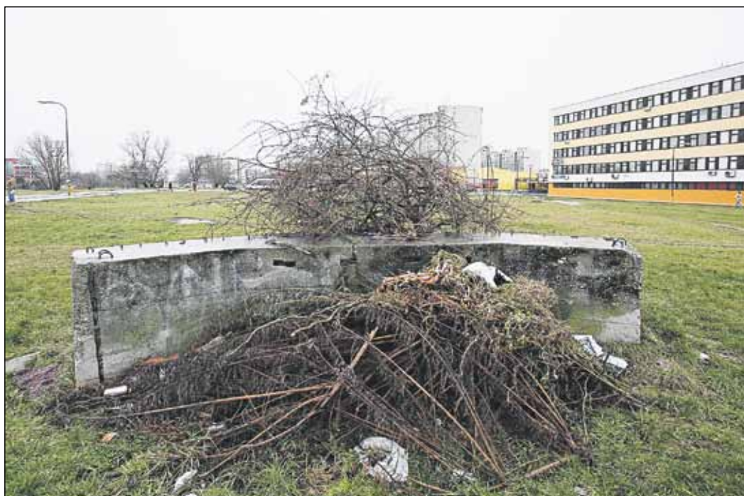
Stena so strielnou pre protitankový kanón pri Jantárovej ceste.
