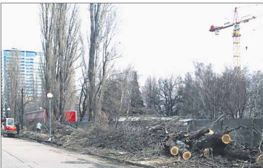
Stromová alej na Kalinčiakovej ulici musela začiatkom marca definitívne ustúpiť výstavbe spojenej s novým zimným štadiónom.
