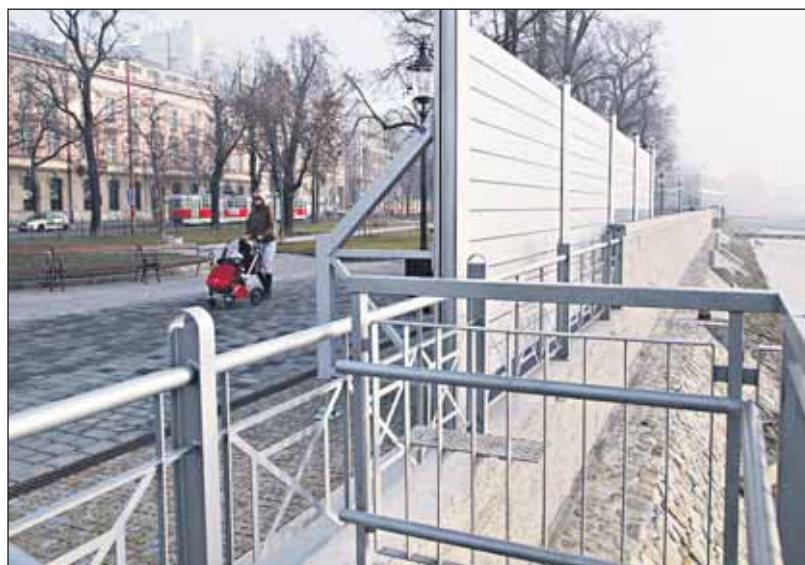
Vďaka protipovodňovej ochrane by sa už nemala zopakovať situácia z augusta 2002, keď sa voda z Dunaja dostala až na Šafárikovo námestie.
